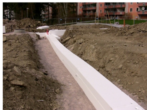
Lock på isolering efter utrullning av rör
