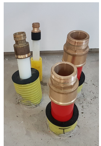
Efter gjutning och provtryckning
