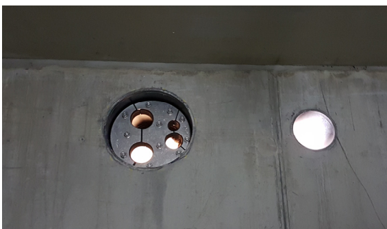
Måttanpassning och montage av HRD-tätning
